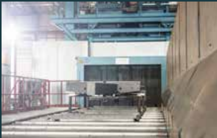
Pretratamiento mecánico por chorro de arena para superficies limpias y homogéneas
